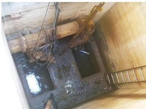
Figura 3.3.1.1.3 Poço de sucção
