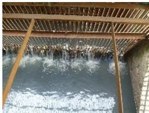
Figura 3.3.1.1.21 Gradeamento
