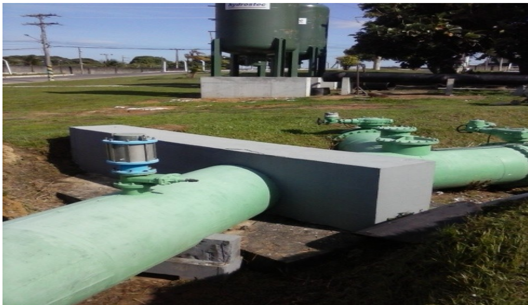
Válvula Quebra Vácuo Barrilete Alto 2 - Ponta do Ismael
