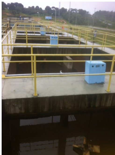
Figura 3.2.2.12.5 Floculador em manutenção
