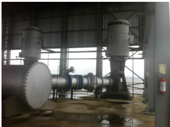
Elevatória de Água Bruta
