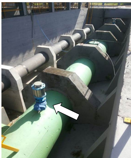
Barrilete Alto 2 – Substituição de ventosas para válvulas quebra vácuo – Detalhe 1
