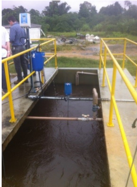
Estrutura de Entrada da Água Bruta
