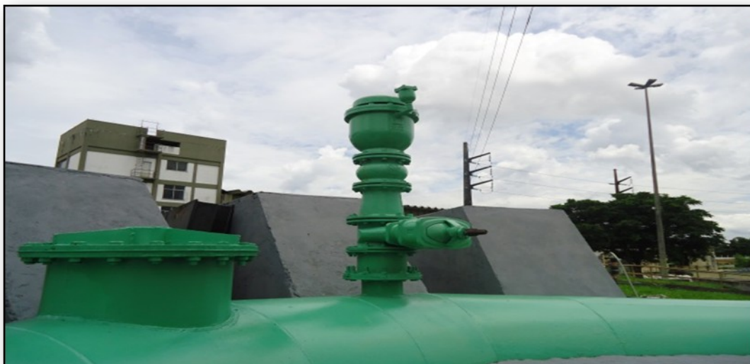
Válvula Quebra Vácuo da Elevatória – Ponta do Ismael
