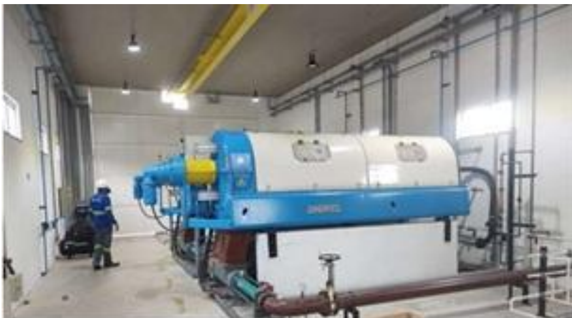
Figura 19 – Sala operacional do sistema de tratamento de lodo da ETE Timbiras
