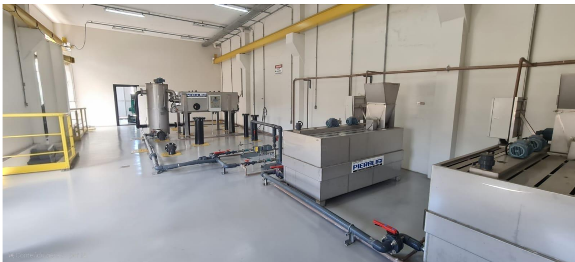
Figura 18 – Sala operacional do sistema de tratamento de lodo da ETE Educandos
