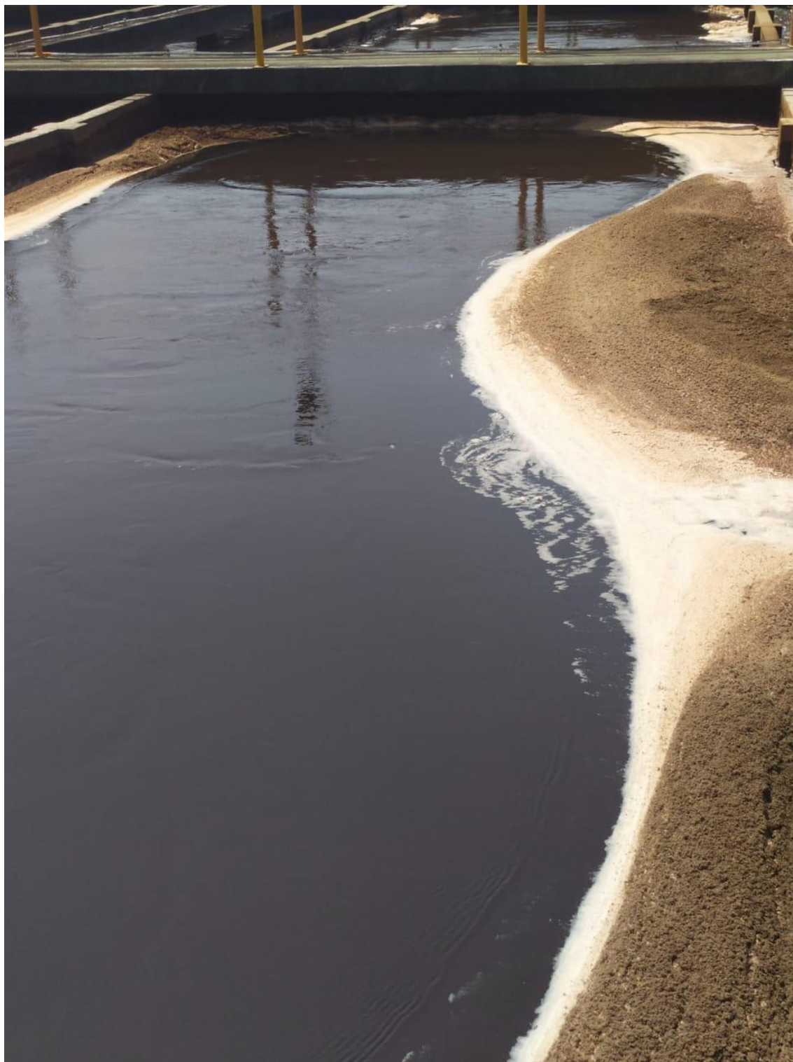
Figura 20 – Processo de Floculação
