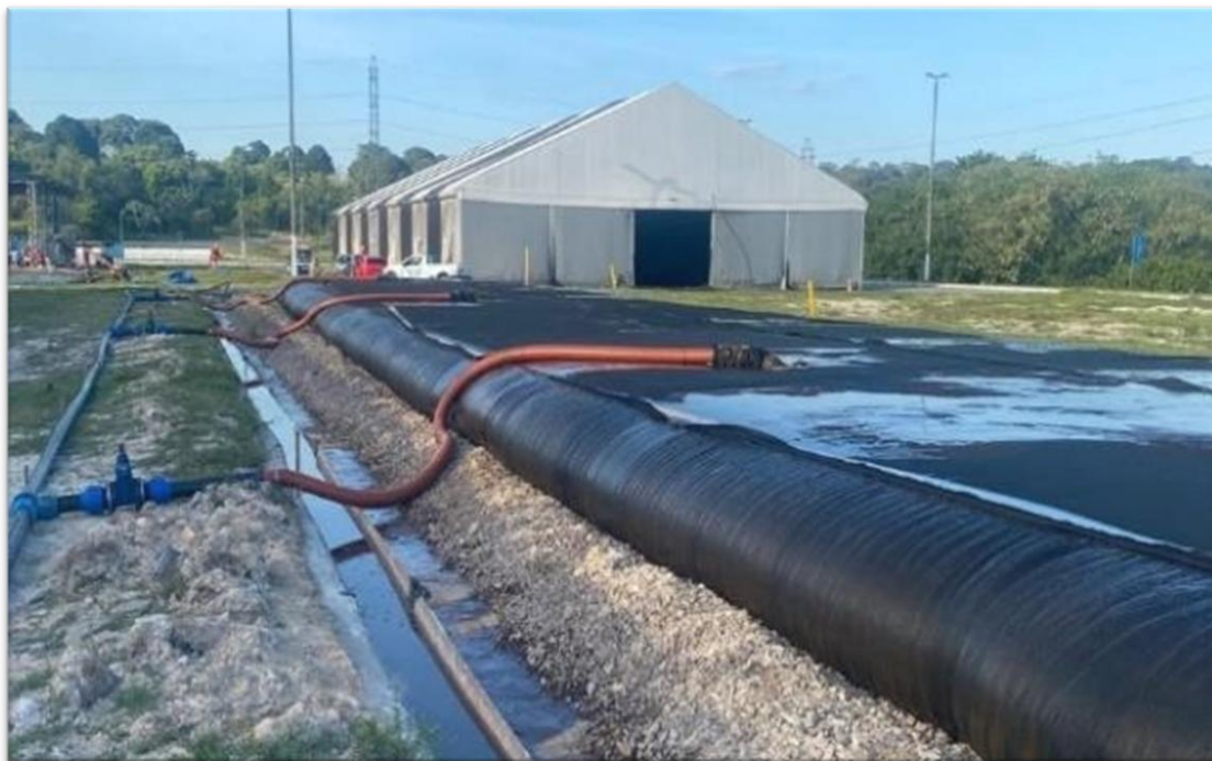
Figura 38 – Tanque de sedimentação auxiliar do sistema de tratamento do lodo da ETA Ponta das Lajes
