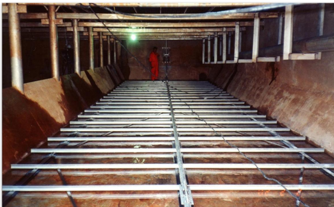
Figura 22 – Raspadores de fundo dos decantadores
