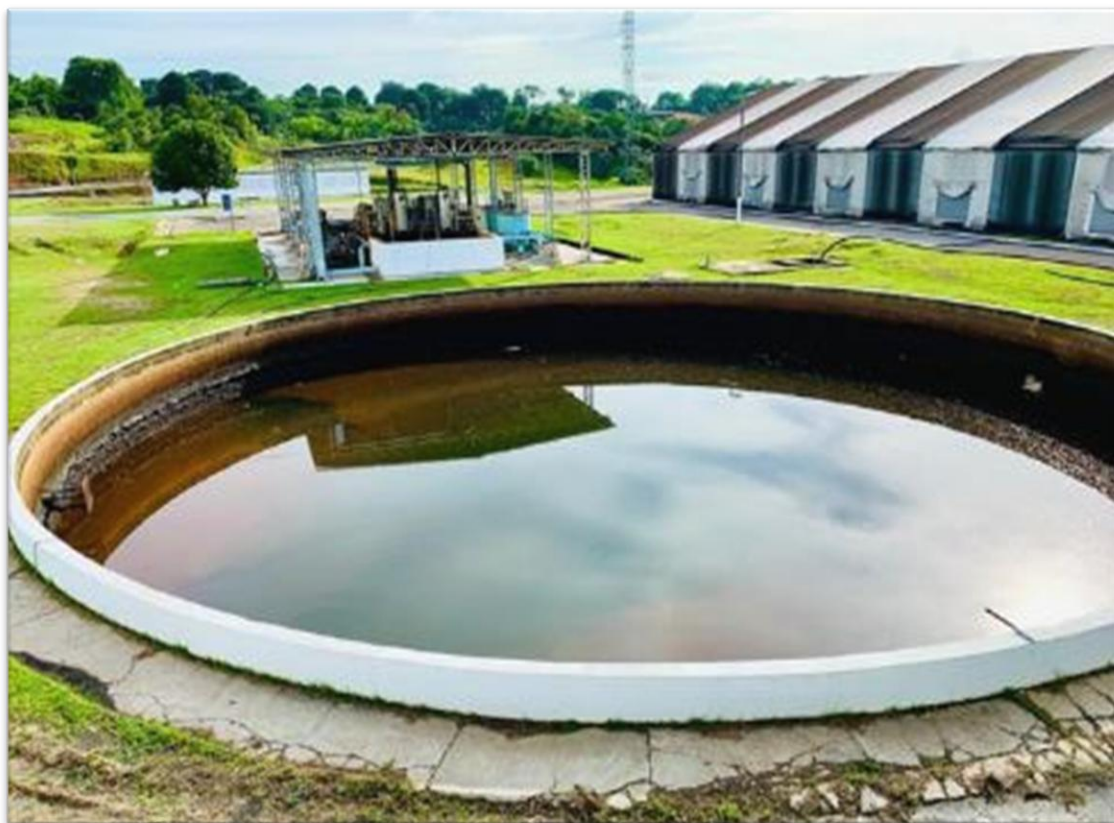
Figura 33 – Tanque de recebimento de água de lavagem dos filtros
