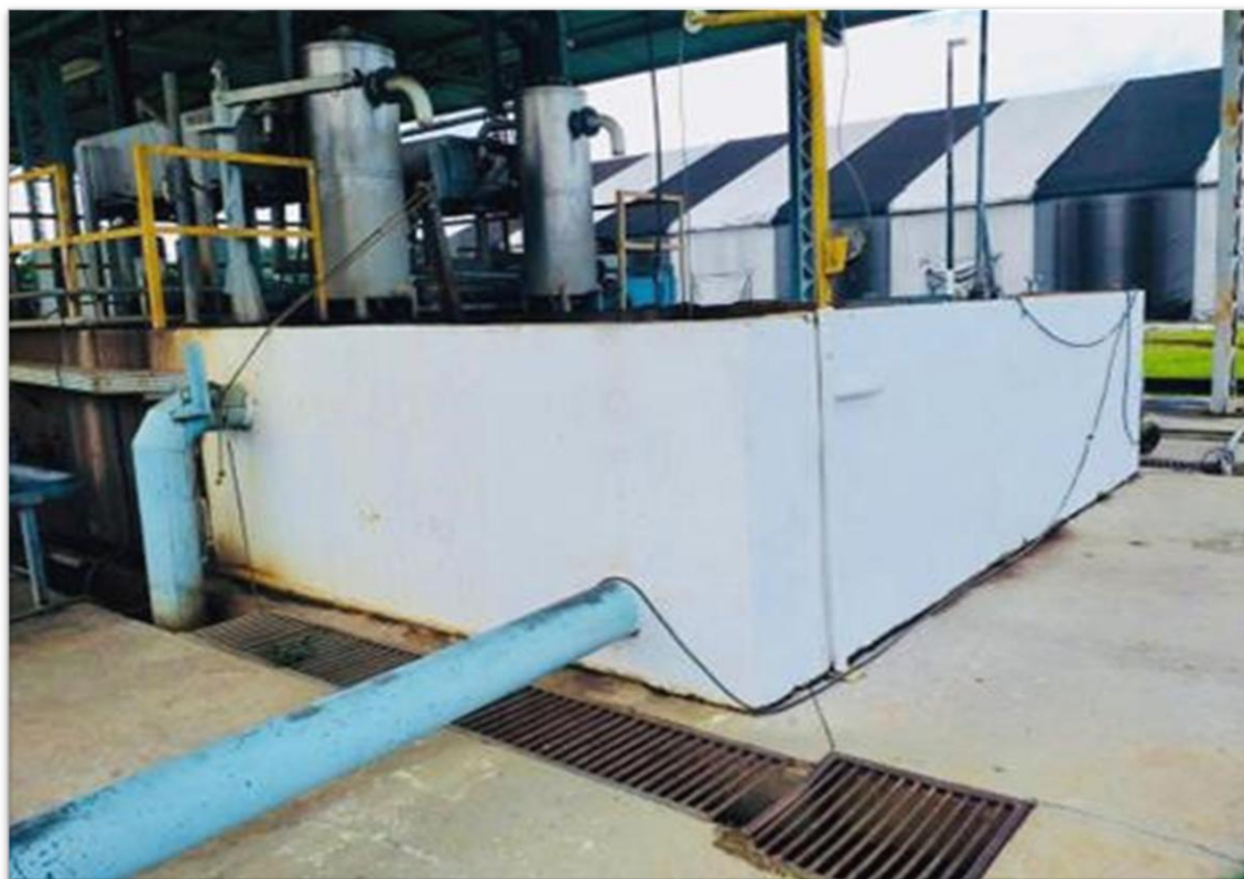
Figura 35 – Tanque de recebimento e homogeneização do lodo dos decantadores
