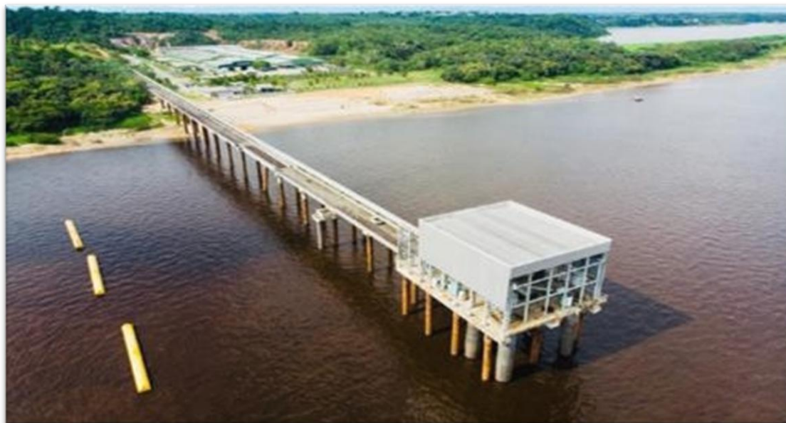
Figura 30 – Captação de água bruta da ETA Ponta das Lajes – Complexo PROAMA.
