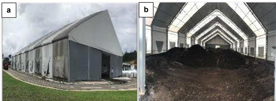
Figura 36 – Galpão do processo de inertização e secagem do lodo da ETA Ponta das Lajes. (a) Galpão do processo de inertização. (b) Galpão de secagem do lodo da ETA Ponta das Lajes
