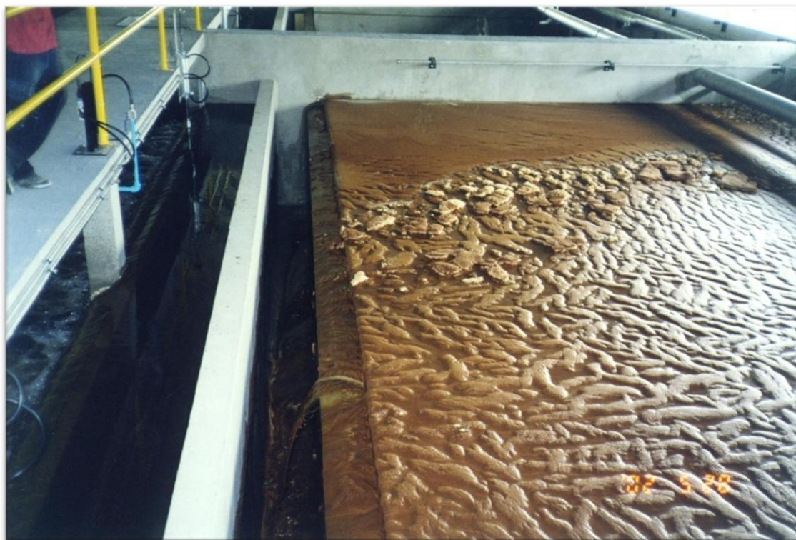
Figura 25 – Lodos flutuantes do sistema de flotação da ETA-2
