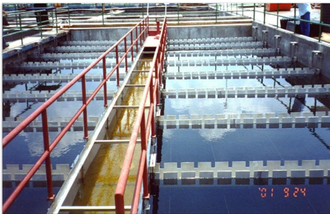
Figura 21 – Decantadores da ETA-1
