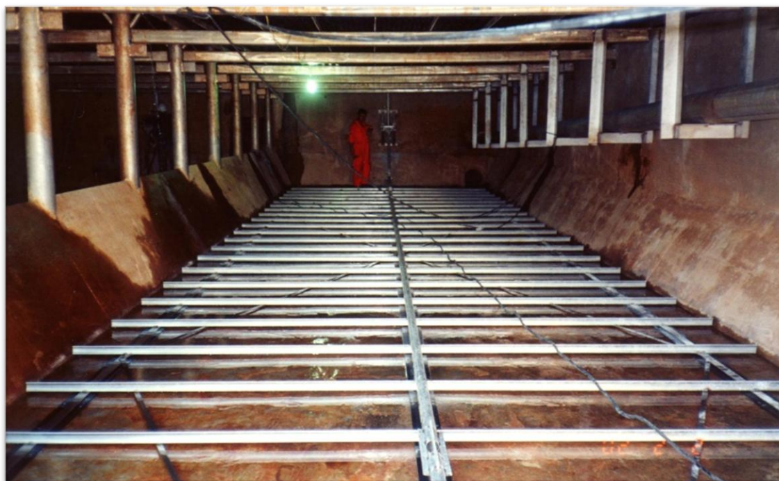
Figura 22 – Raspadores de fundo dos decantadores
