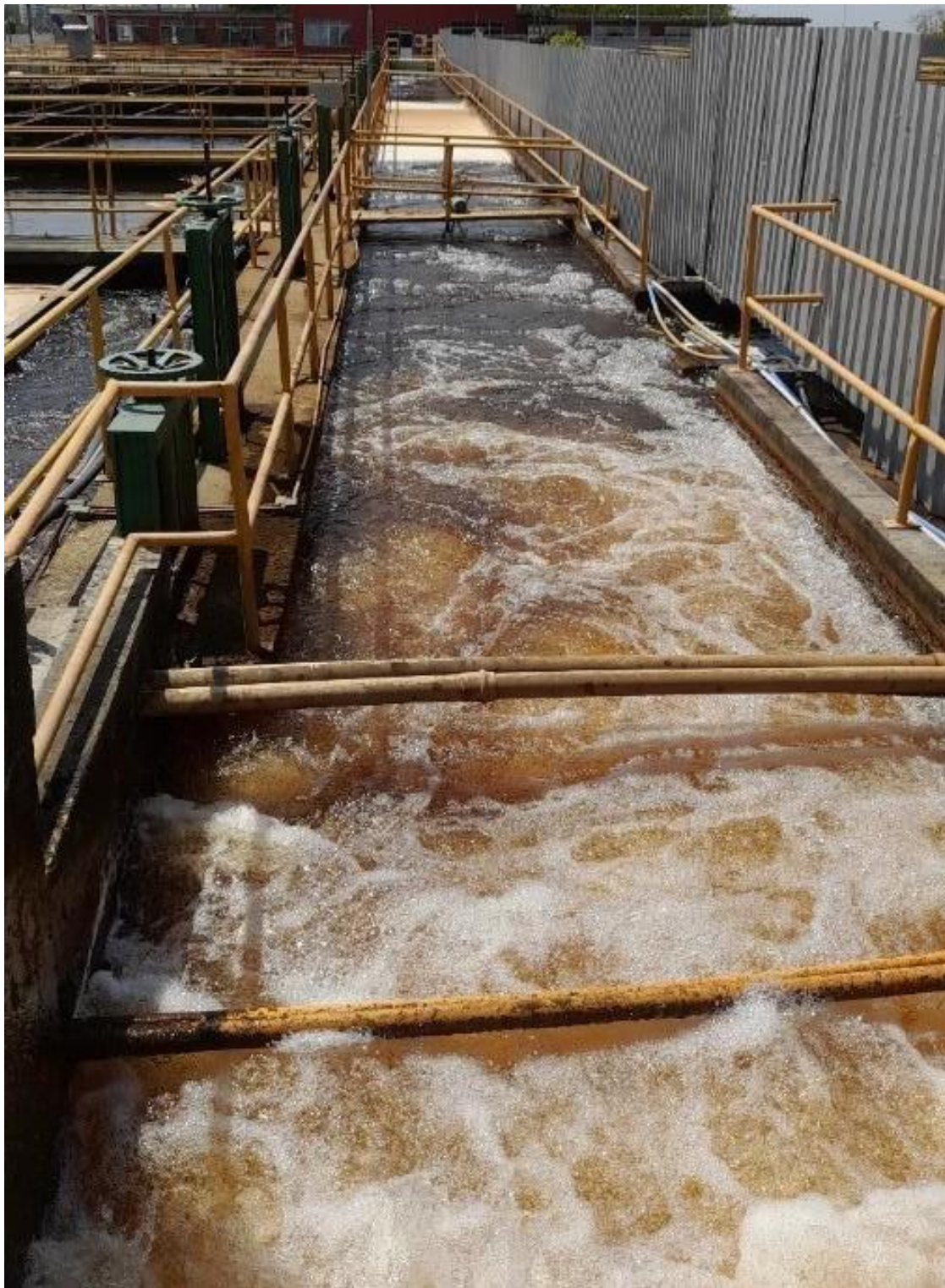
Figura 19 – Adição de coagulante – Mistura rápida
