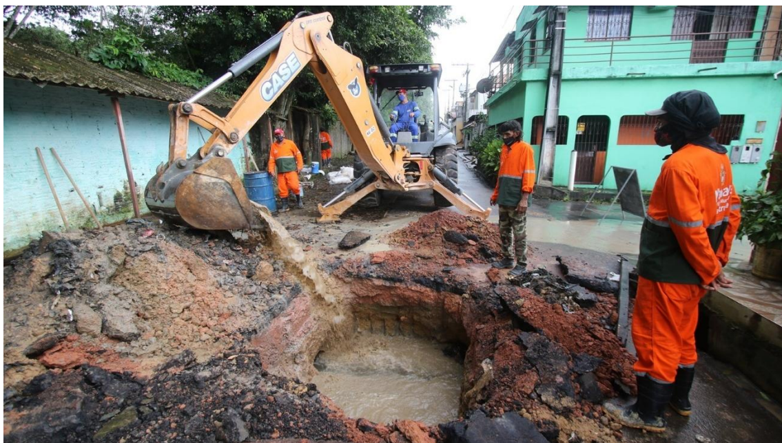
Figura 66 – Reparação de roturas
