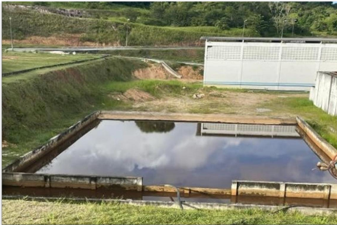
Figura 37 – Geoforma do sistema de tratamento do lodo da ETA Ponta das Lajes
