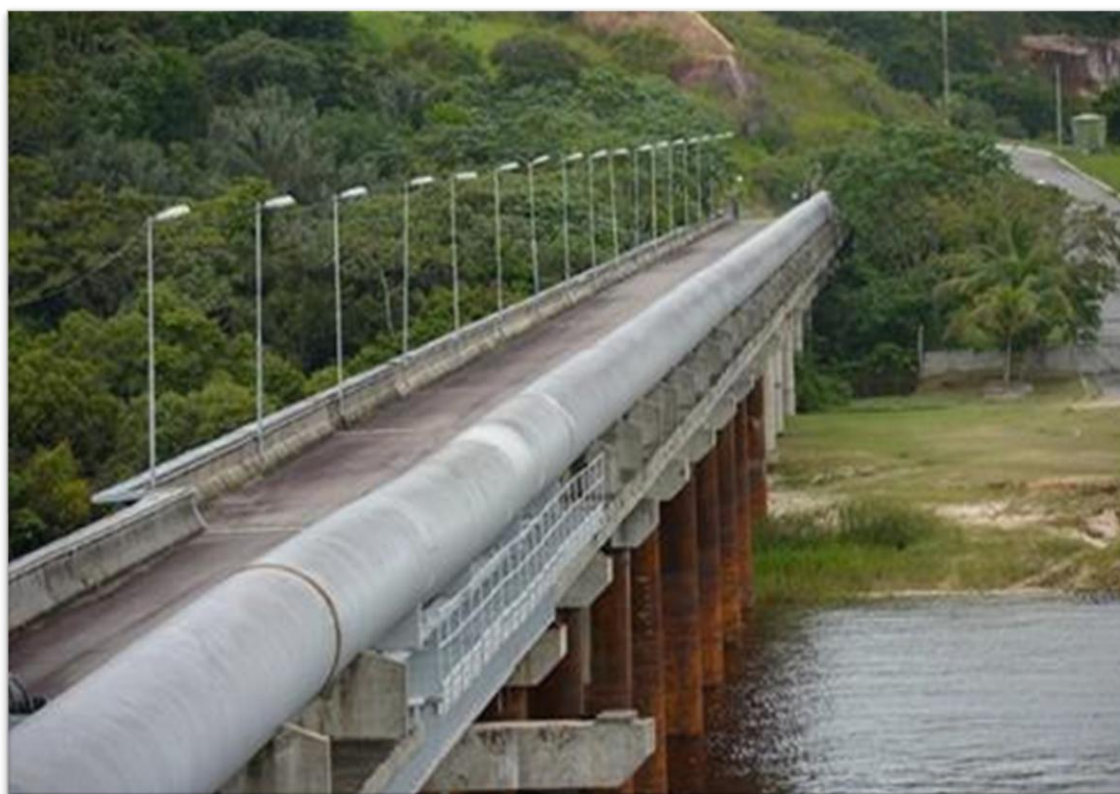
Figura 31 – Adutora de água bruta da ETA Ponta das Lajes do Complexo PROAMA
