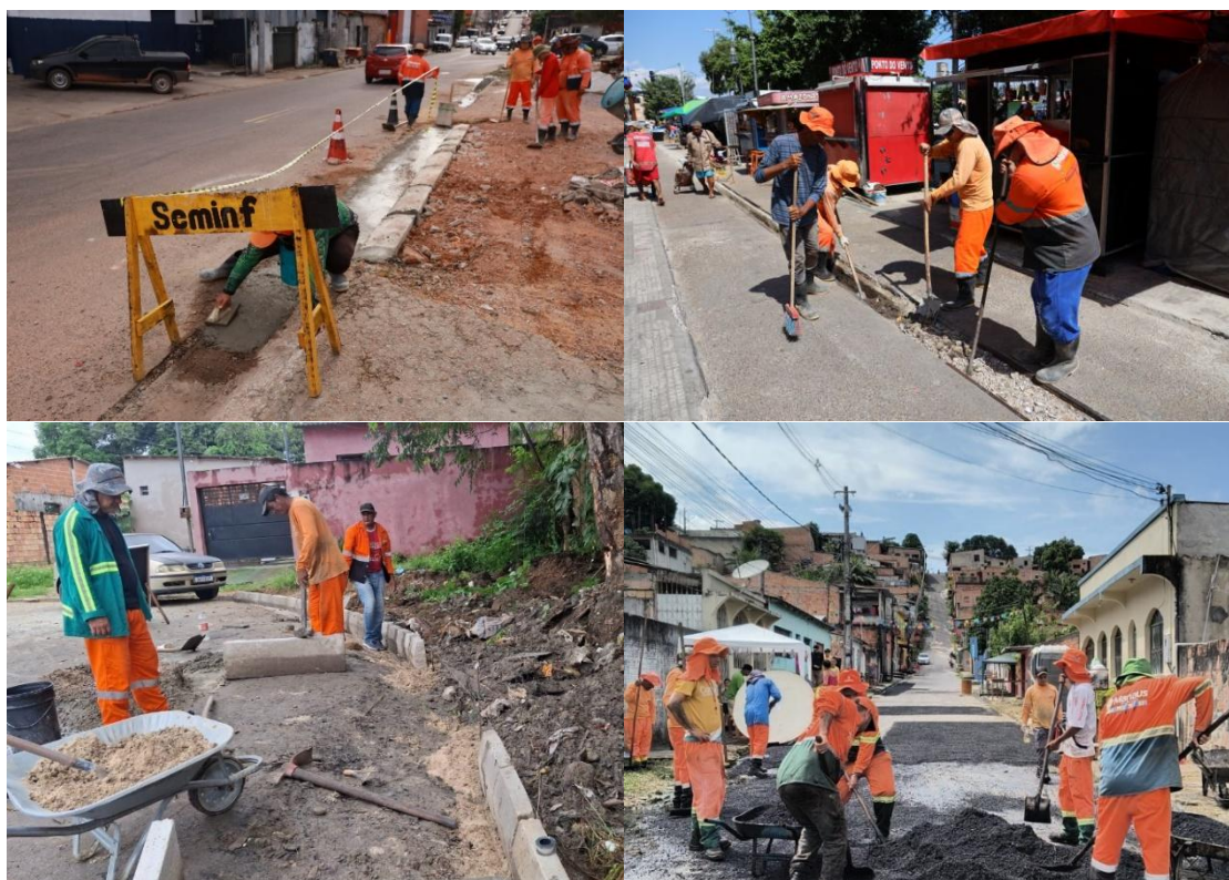
Figura 73 – Manutenção de meio-fio, sarjeta e vias públicas de Manaus-AM
