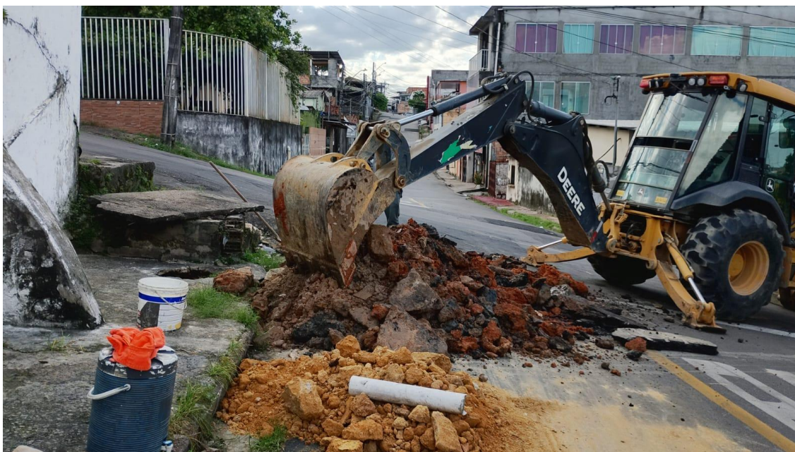
Figura 89 – Anelamento da tubulação
