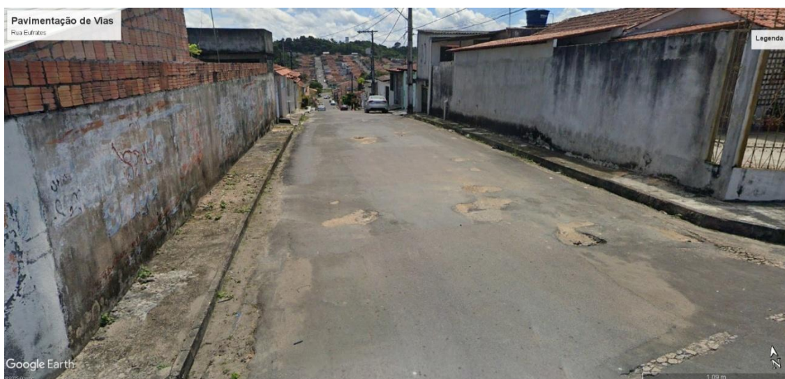
Figura 56 – Patologias no revestimento em via periférica de Manaus-AM
