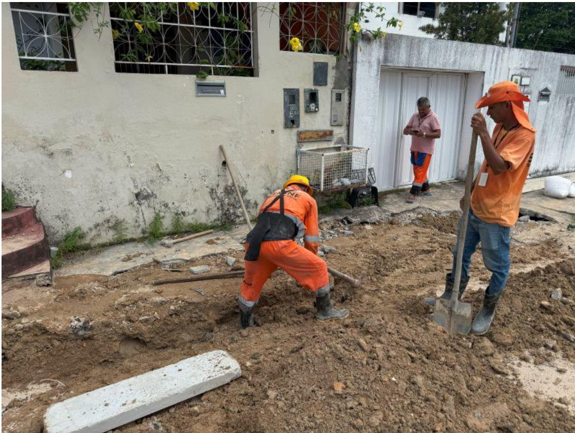
Figura 91 – Manutenção da rede de drenagem
