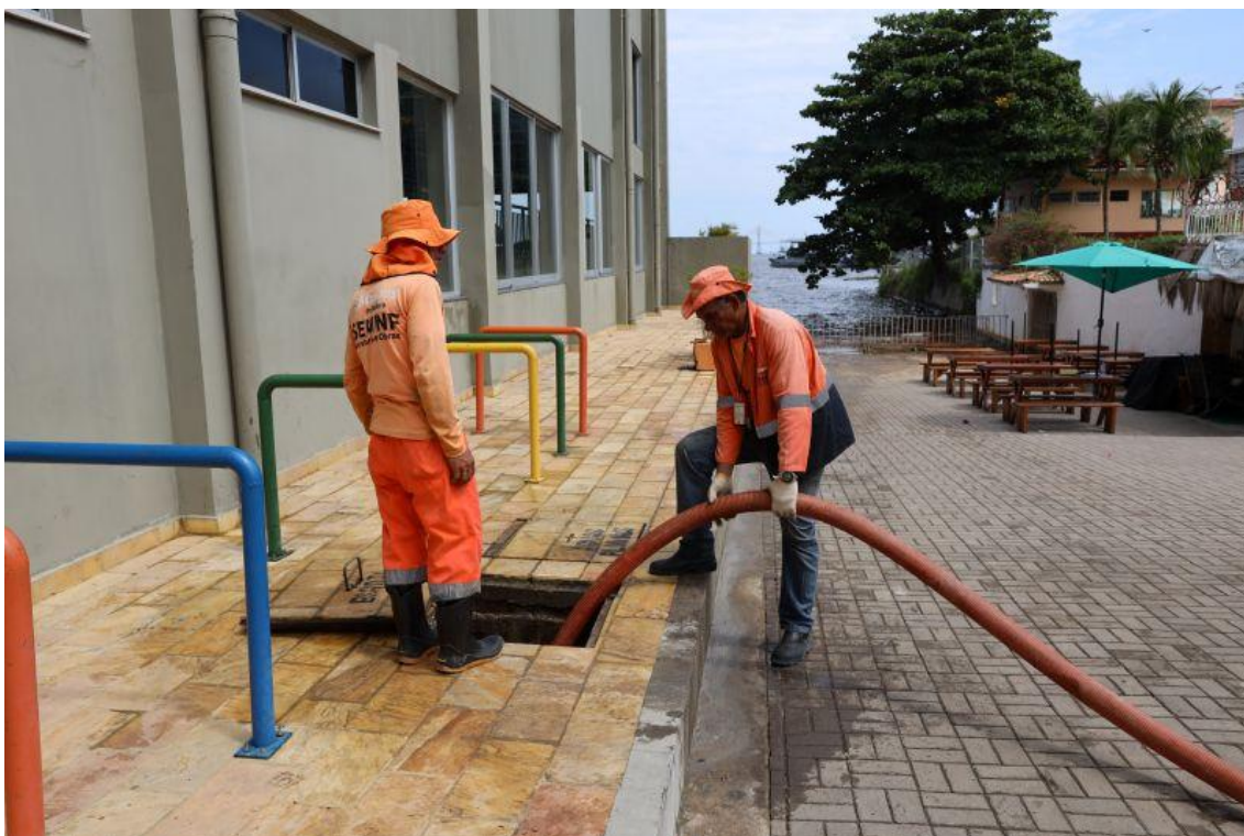
Figura 88 – Desobstrução de caixas coletoras
