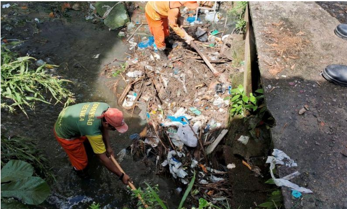
Figura 86 – Limpeza da rede de drenagem
