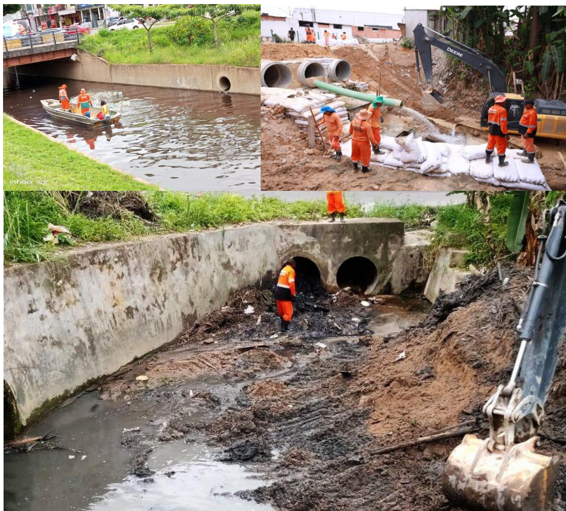
Figura 70 – Instalação de exutórios
