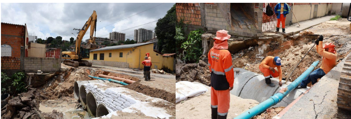
Figura 69 – Recuperação e instalação de tubulação do exutório
