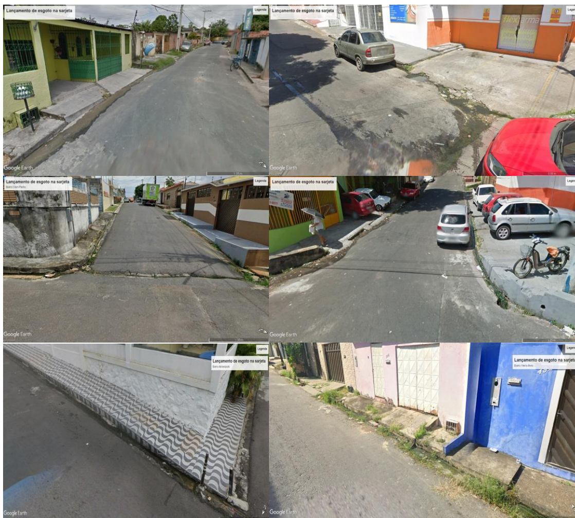
Figura 110 – Lançamento de esgoto no sistema de drenagem em Manaus-AM
