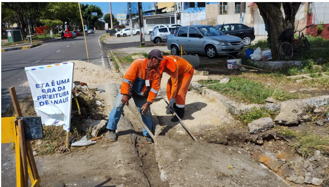
Figura 90 – Anelamento e substituição de trechos da rede de drenagem
