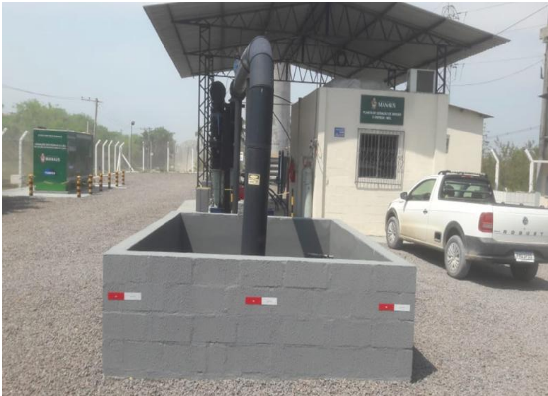
Figura 81 – Caixa separadora de condensados
