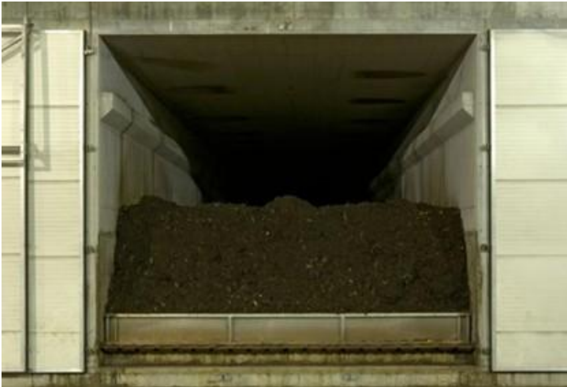
Figura 151 – Usina de Compostagem (em túnel)
