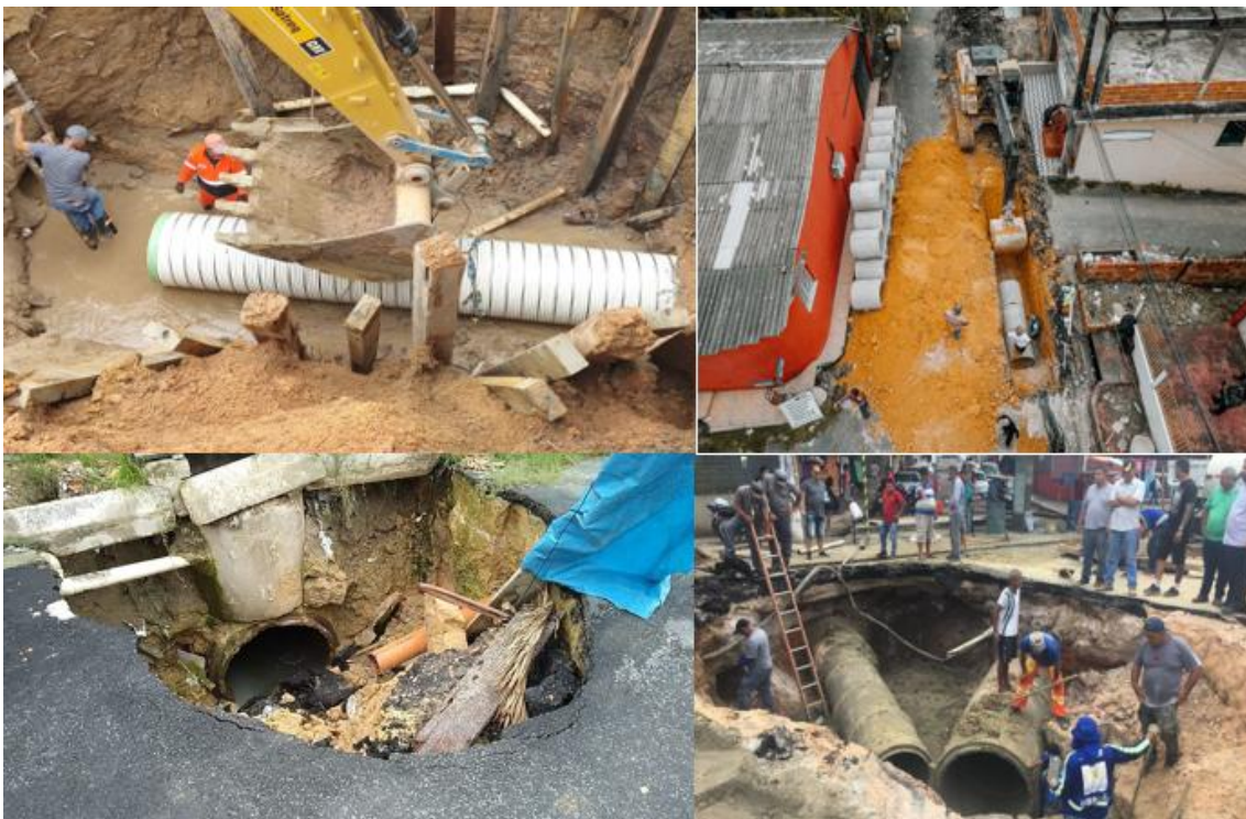
Figura 157 – Problemas com a drenagem em decorrência de chuvas intensas
