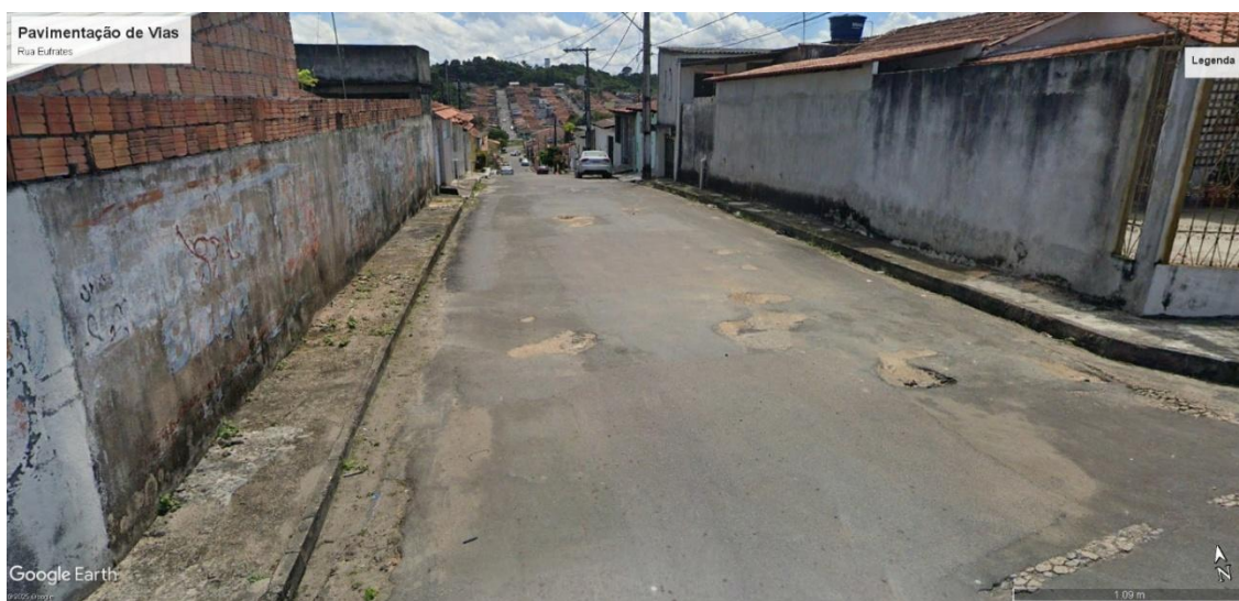
Figura 56 – Patologias no revestimento em via periférica de Manaus-AM
