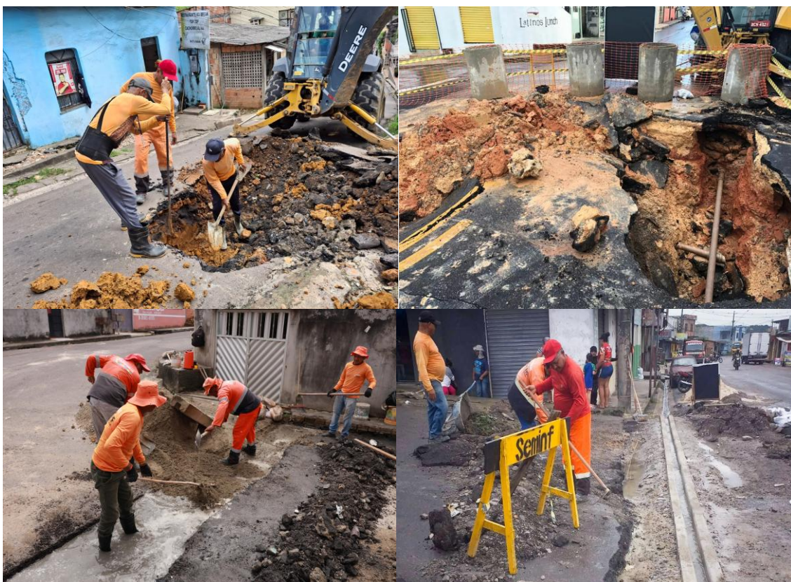
Figura 57 – Problemas na drenagem urbana decorrentes das patologias no revestimento das vias
