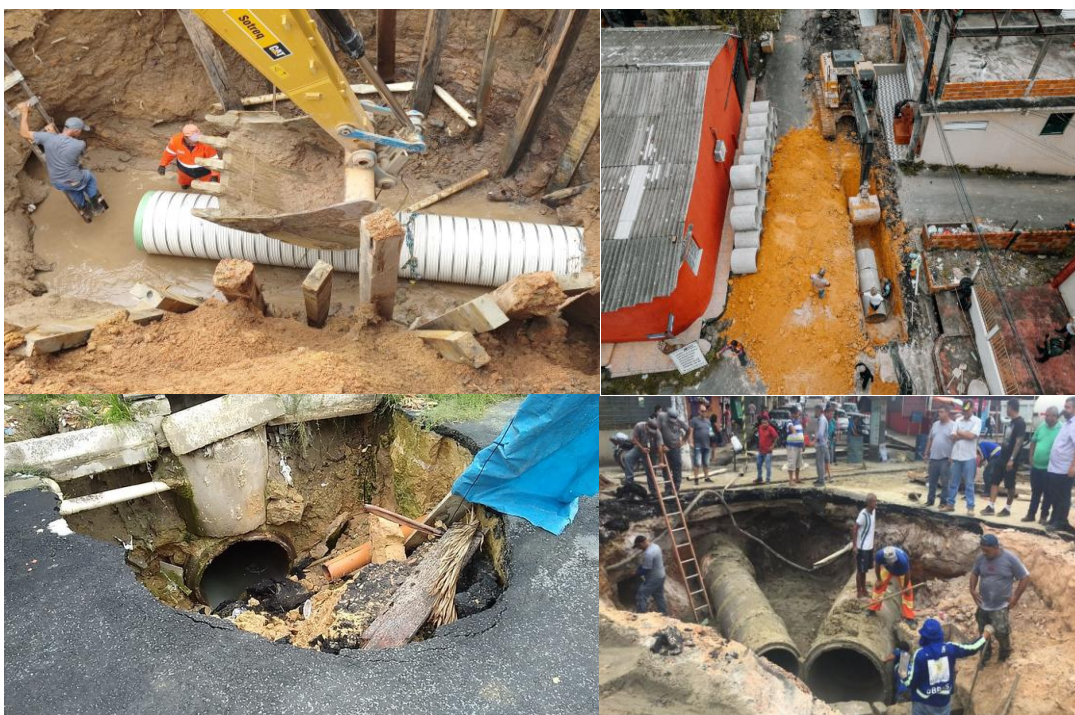
Figura 111 – Problemas com a drenagem em decorrência de chuvas intensas
