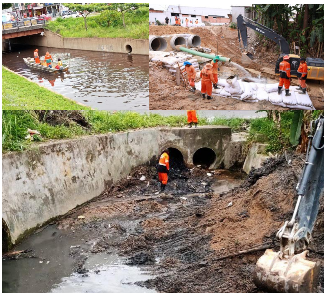
Figura 70 – Instalação de exutórios
