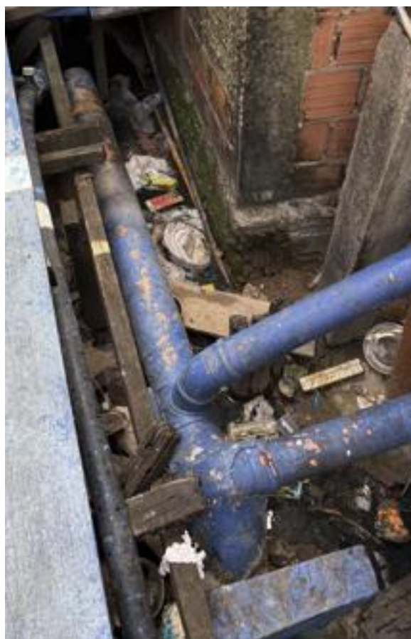
Figura 155 – Ligações de esgotos em zona de casas de palafitas
