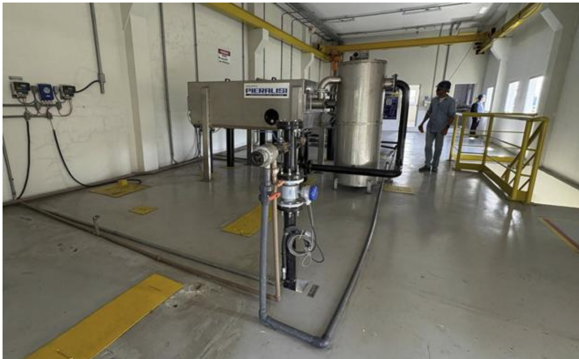
Figura 59 – Vista etapa de processamento de lodos da ETE de Educandos
