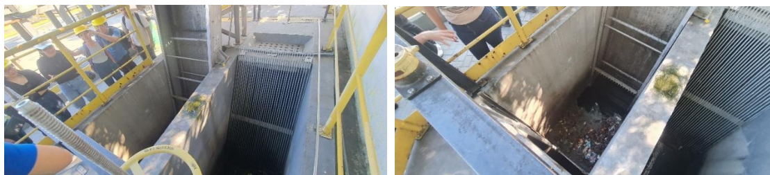
Figura 23 – Vista geral do sistema de gradeamento da Estação de Tratamento de Esgoto (ETE) Educandos
