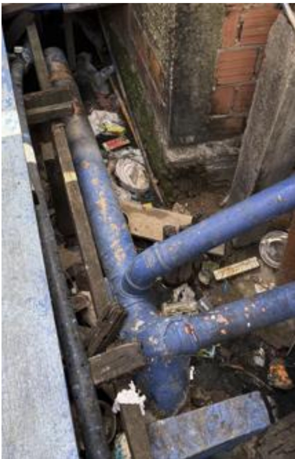
Figura 42 – Ligações de esgotos em zona de casas de palafitas
