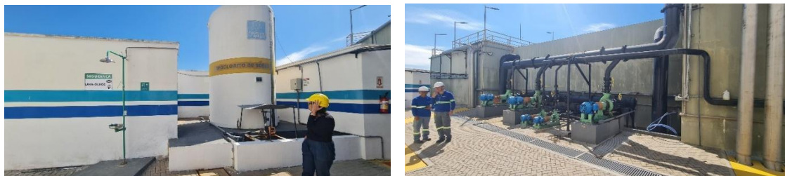
Figura 27 – Vista dos sistemas de cloração e de bombeamento do lodo da ETE Educandos
