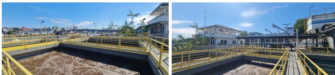
Figura 25 – Vista geral dos reatores biológicos do tipo MBBR/IFAS da ETE Educandos
