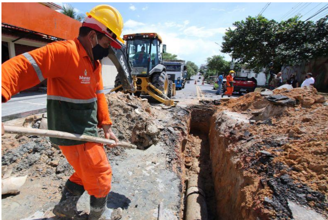
Figura 50 – Manutenção de redes de esgotamento sanitário
