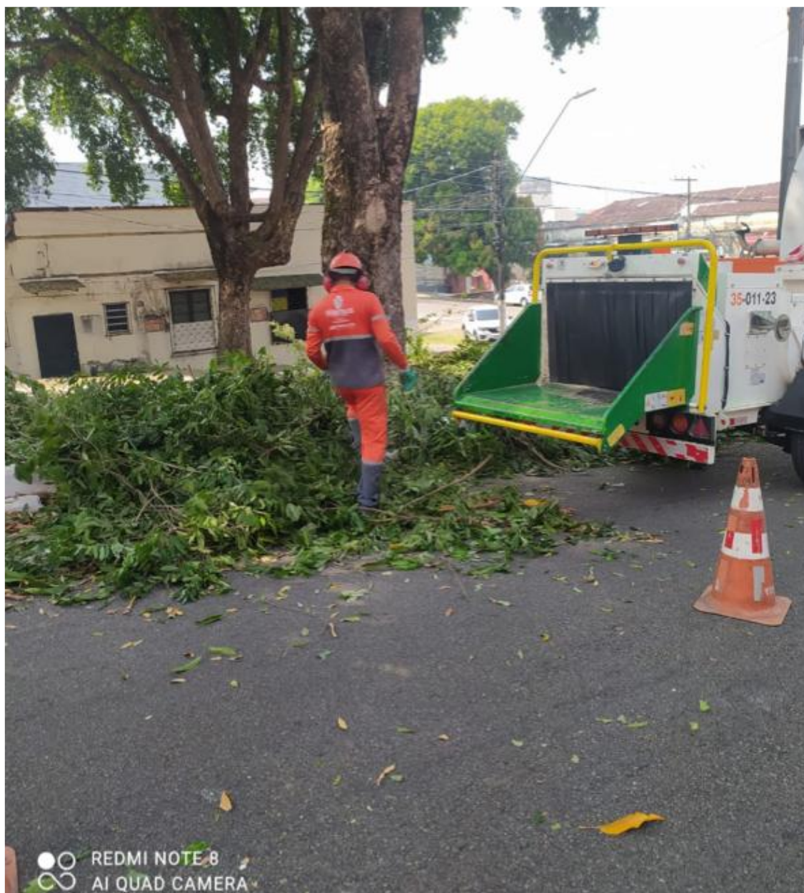
Figura 34 – Coleta de podas com triturador 3
