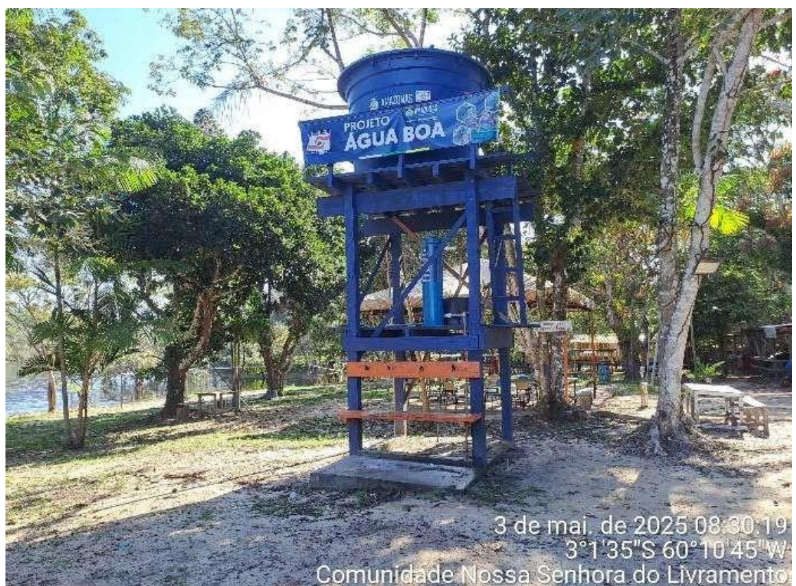
Figura 14 – Poço e o reservatório de água (SAC 01)
