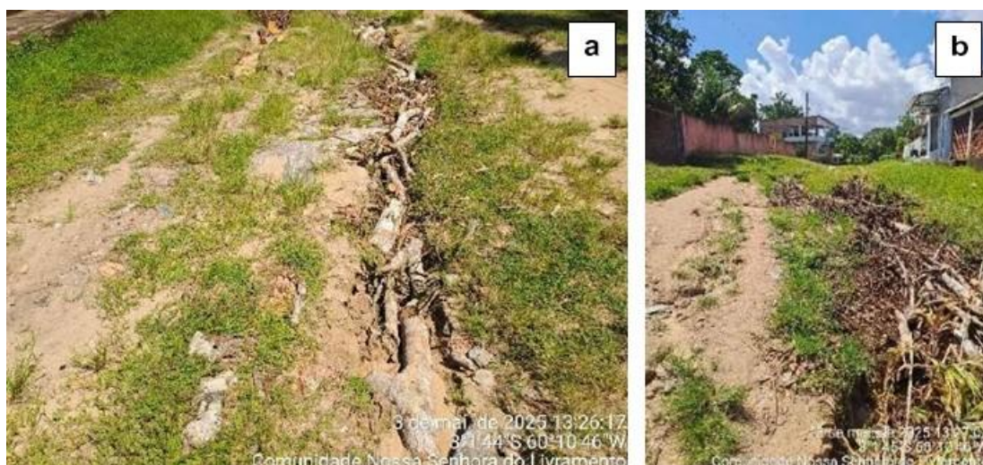
Quadro 42 – Vias de acesso preenchidas com galhos de madeira com intuito de evitar erosão
