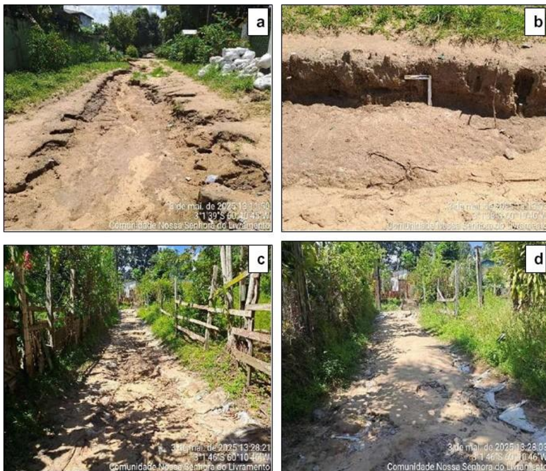
Quadro 40 – Erosão das vias internas (A e B); (C): Diferença de nível do terreno onde ocorreu erosão; (D) rip-rap improvisado pelos moradores
